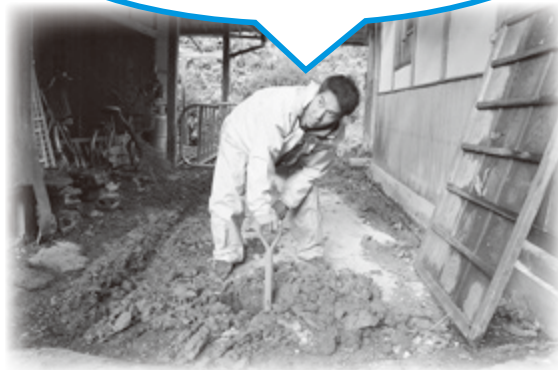
↑ 空き家の水回り改善で穴掘り
