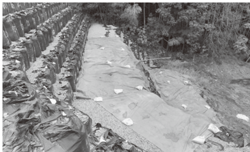
ブルーシートによる保全状況
