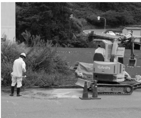
水道仕切弁修理工事
