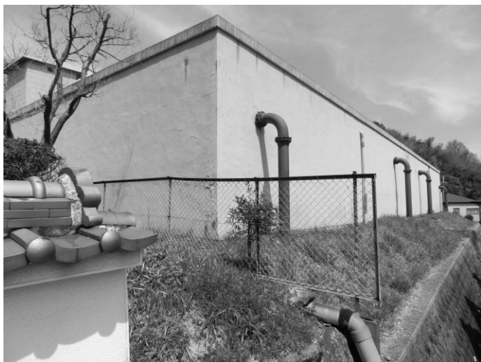
(小吹台低区配水池)
