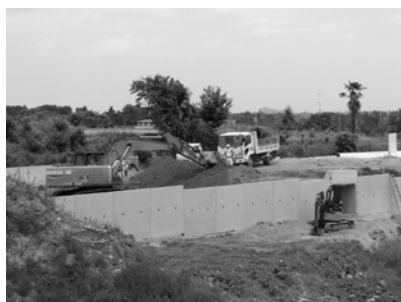
工事が進む309号
