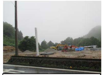
小吹台入口の造成工事現場
