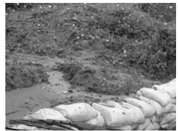
土砂災害現場
