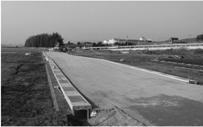
▲（仮称）村道大森線新設工事（森屋地区）
