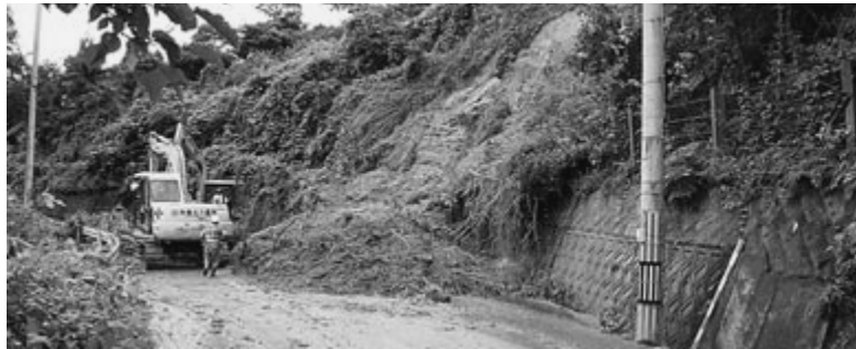
府道富田林五条線への崩落箇所
