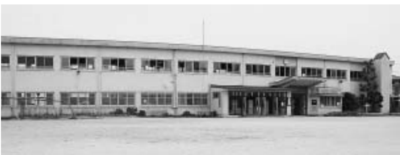
今年度、耐震補強工事を予定している赤阪小学校
