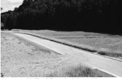
整備が進む小吹処分場
