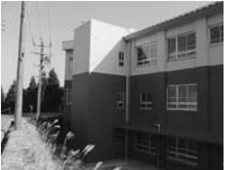
エレベーター棟
