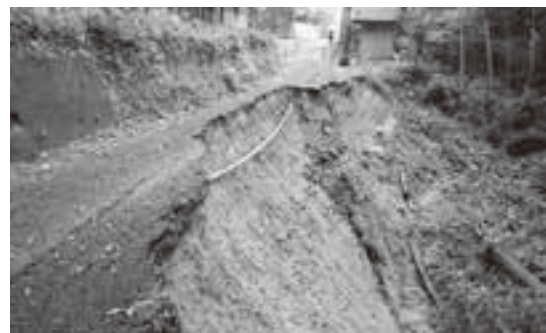
道路崩壊 中津原(日出目虎谷線)
