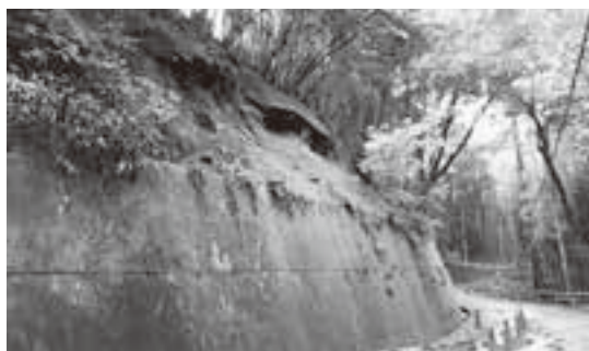
法面吹付崩壊 小吹（西峯唐谷線）
