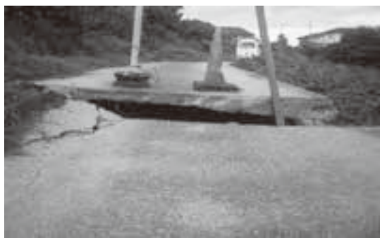
農道陥没 森屋（カケヒ高塚農道）
