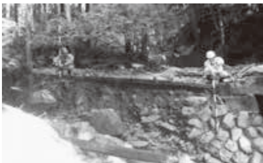
林道崩壊 千早(長谷線)
