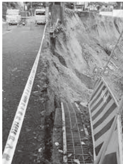
(10月1日 村道側溝路肩崩落)
