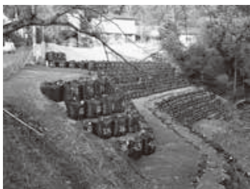
※応急復旧工事（大型土のう設置）
