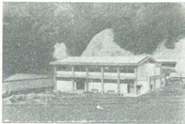
完成した体育館
