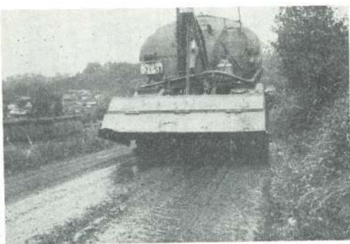
村道舗装完成
