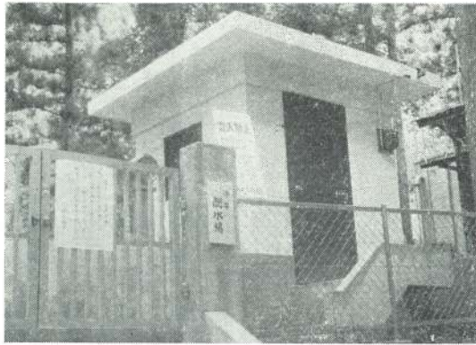
千早地区水源地
