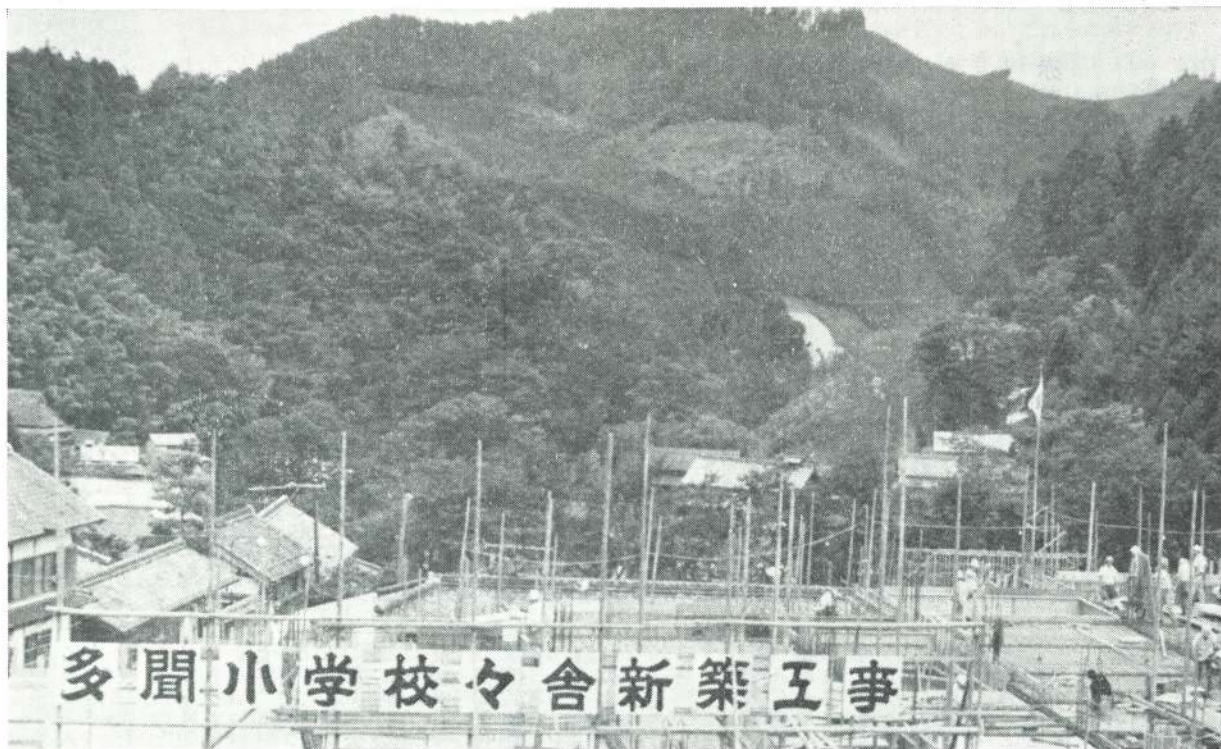
急ピッチで進む多聞小学校工事現場
