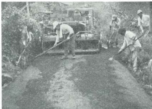
村道アスファルト舗装工事
