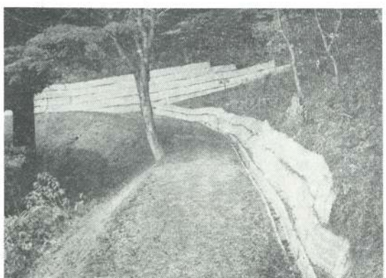
昭和46年度工事起点附近
