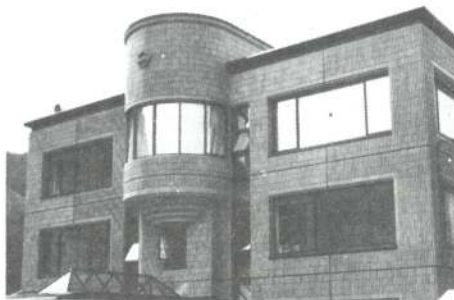
(完成した新庁舎)
