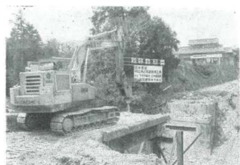
【森屋桐山線拡幅工事】
