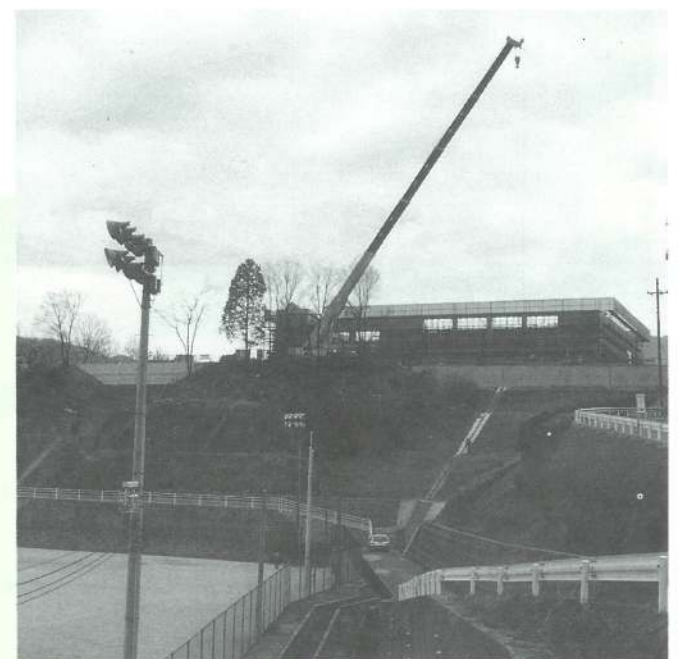
▲工事の進む海洋センター
