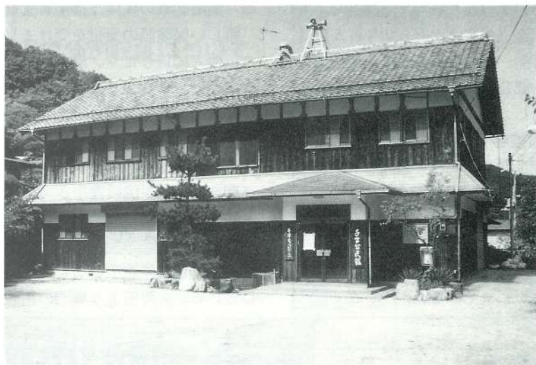
▲ 現在の千早老人憩いの家（昭和54年に改築）
