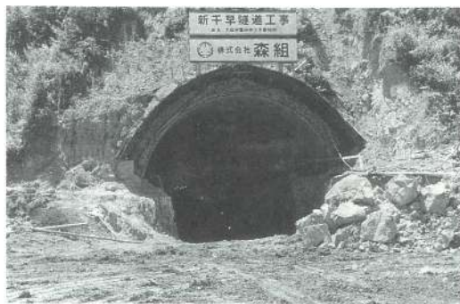
▲工事の進む新千早隧道
