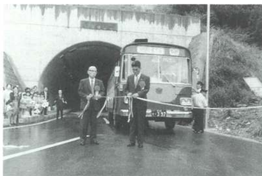
▲新千早隧道完成(昭和50年6月)
