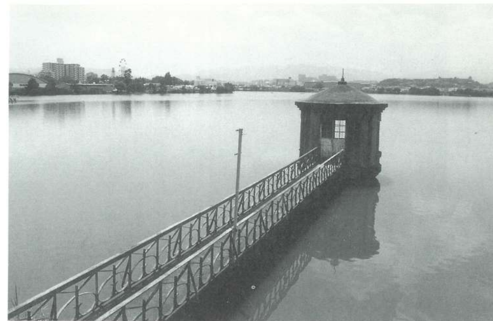
日本最古のため池・狭山池
