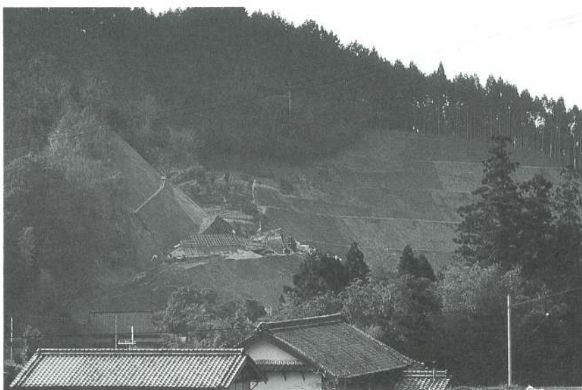
工事の進む広域農道（東阪地内）
