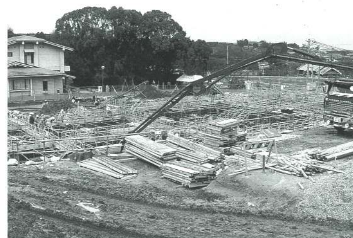
工事の進む（仮称）くすのきふれあいホール
