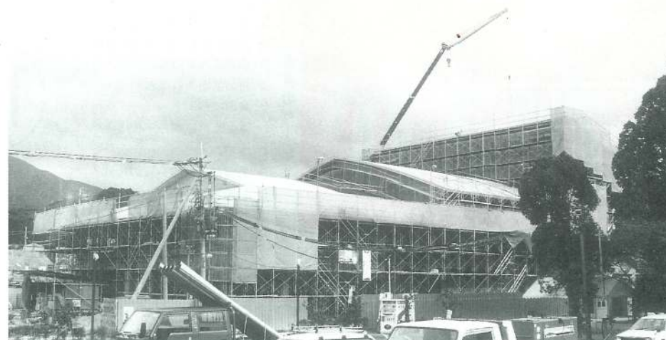
建設の進む(仮称)くすのきふれあいホール
