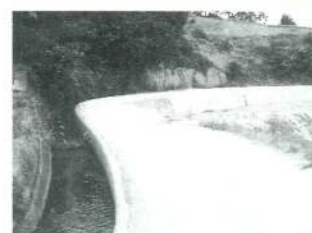
花折水路整備
