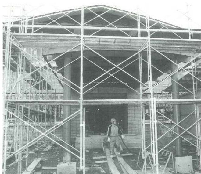
ホールの正面玄関
