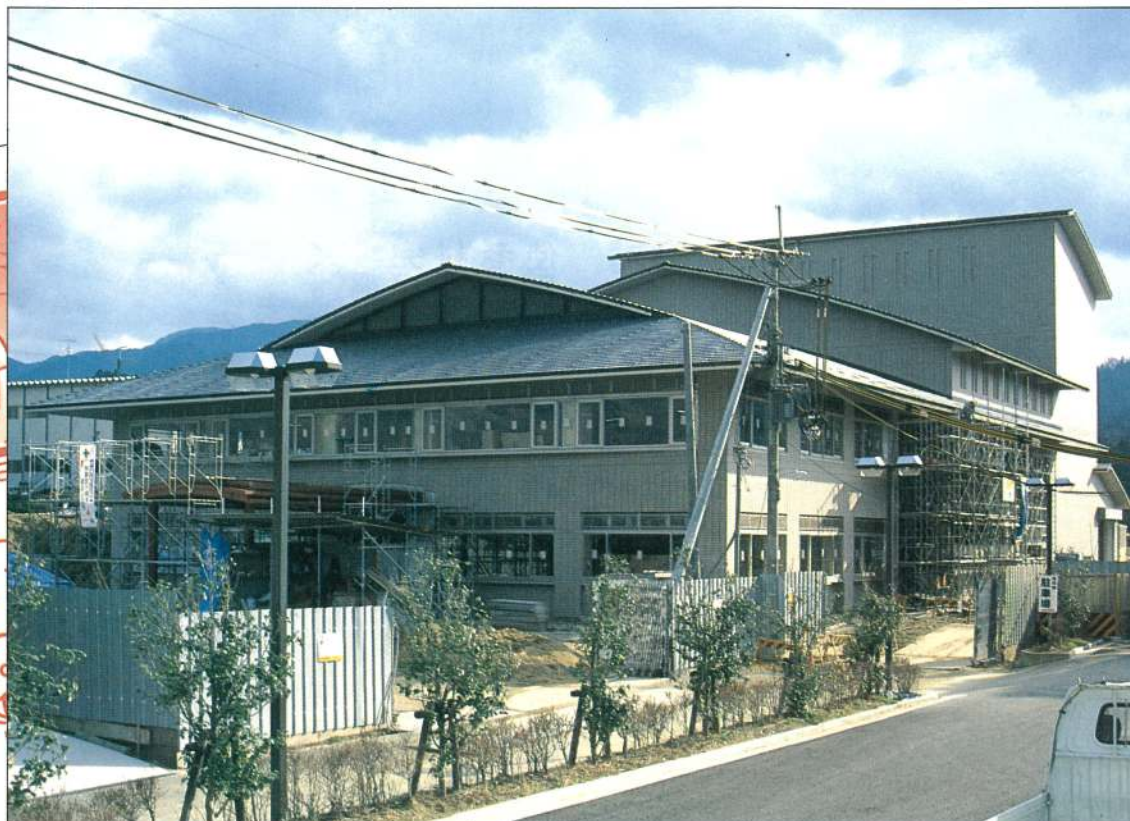
工事の進むくすのきホール
