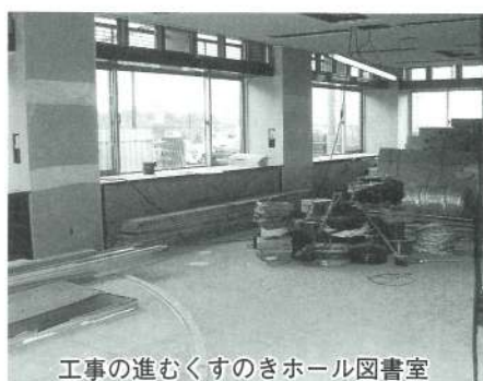
工事の進むくすのきホール図書室
