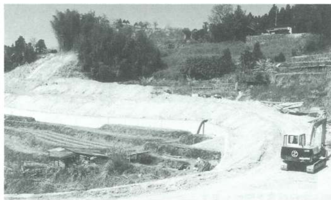
進む広域農道工事
