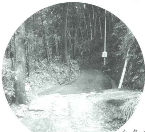
引き続き吉年地区内の道路改良工事を行います
