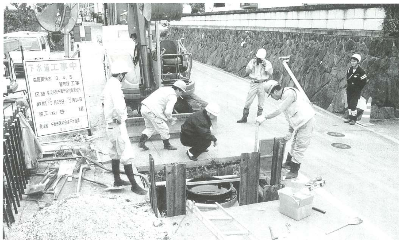
下水道管渠布設工事中のようす
