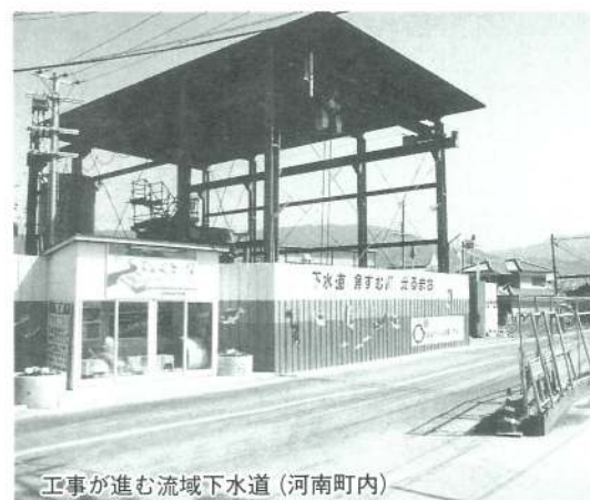
工事が進む流域下水道（河南町内）
