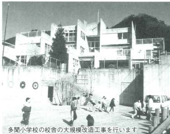
多聞小学校の校舎の大規模改造工事をしています
