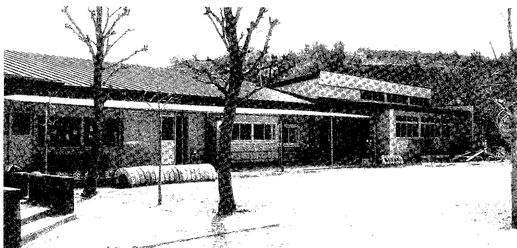
現 赤阪幼稚園園舎
