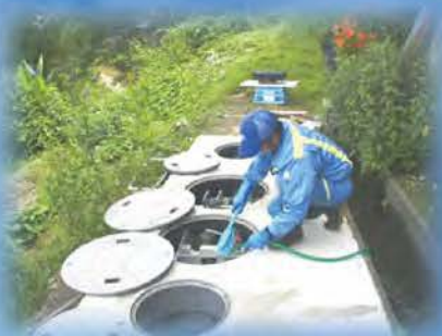
浄化槽点検・清掃業務 昭和 42 年～
