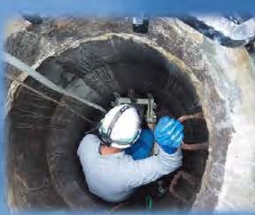
下水道管更生工事 昭和 60 年～
