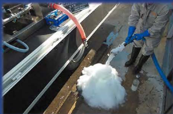
アイスピグ管内洗浄工法（特殊シャーベット） 平成 24 年～
