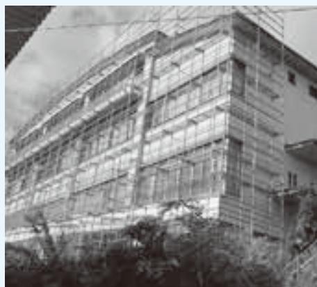
保健センター改修工事
