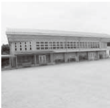
指定避難所（赤阪小学校体育館）
