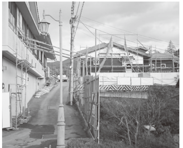
建設中の「認定こども園」
