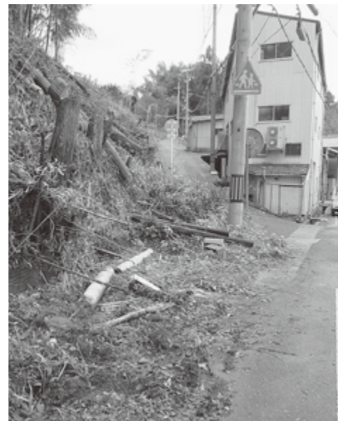
拡幅工事予定地
