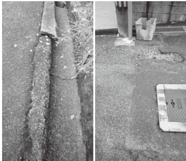
住宅地内の村道・側溝の傷み
