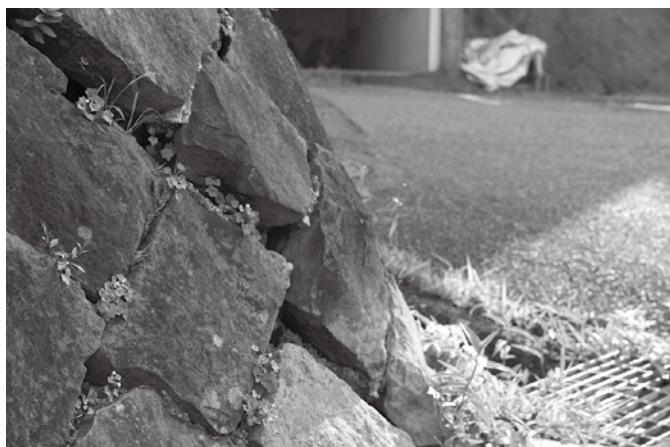
ちびっこ広場補強箇所（一部）
