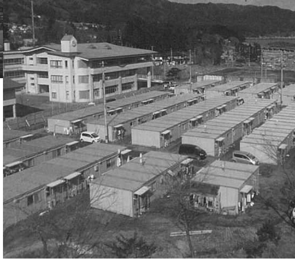
仮設団地 公的仮設
