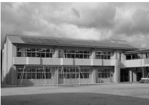
赤阪小学校の太陽光パネル
