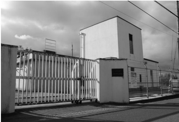
府営水受水場
