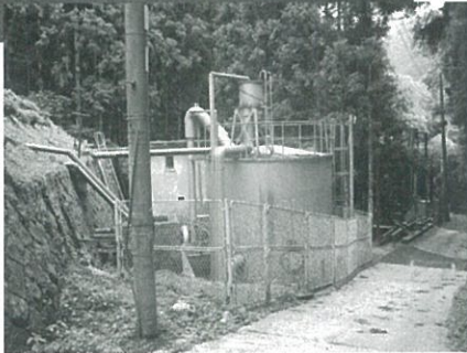
(岩井谷取水施設)
