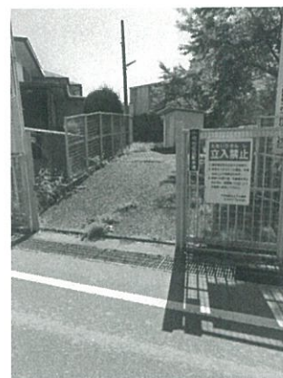
(小吹台配水池)
