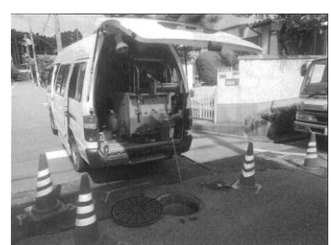
(カメラによる下水道管の調査)
