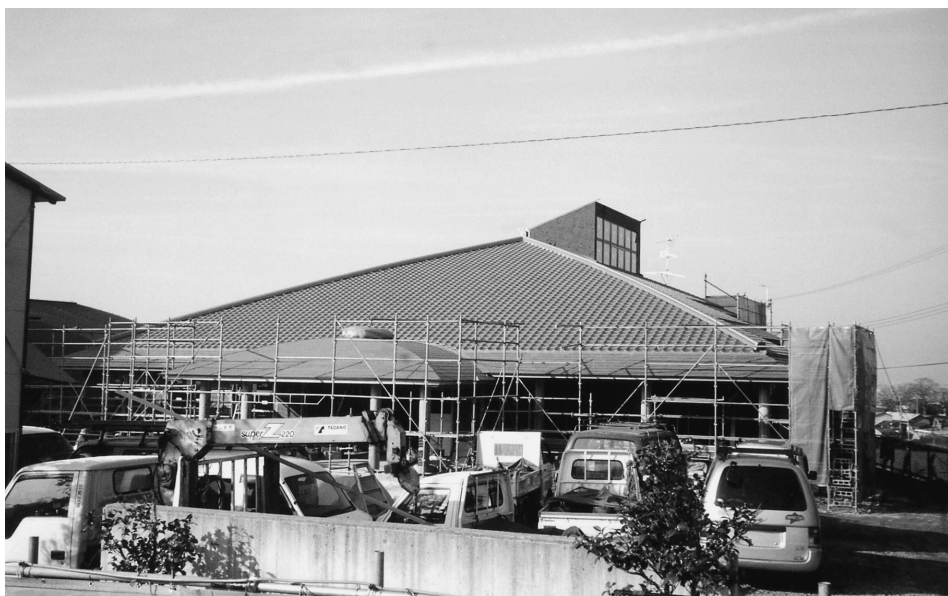
建設中の（仮称）いきいきサロン「くすのき」
