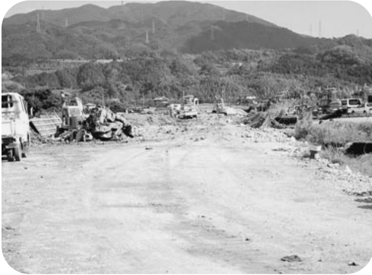
現在工事中の国道309号河南赤阪バイパス
