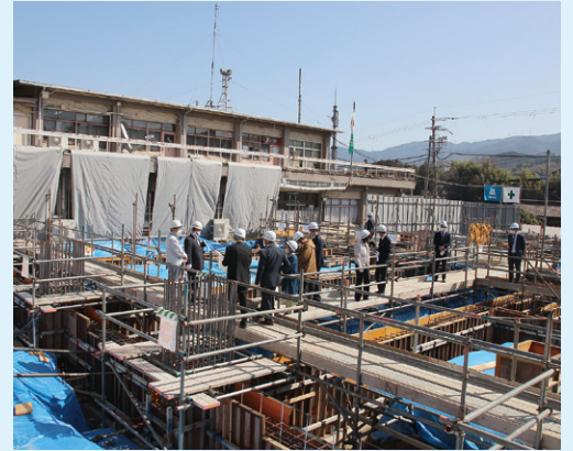
新庁舎工事現場視察
