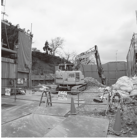
旧庁舎北側解体
