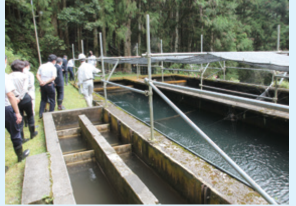
岩井谷浄水場
