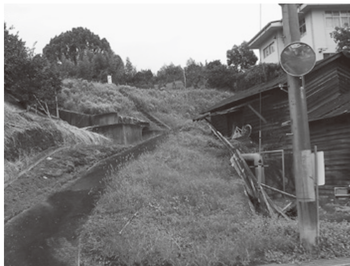
農業用ため池
