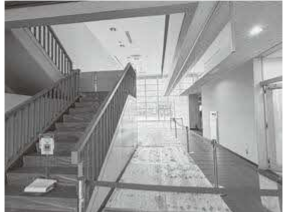
改修工事中のくすのきホール
