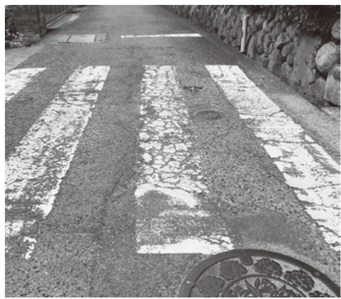
森屋地区道路状況
