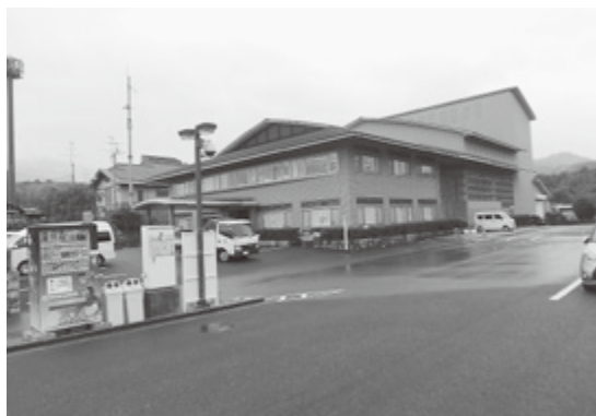
避難所くすのきホール
