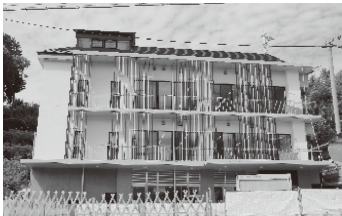
新庁舎（第1期工事完成）
