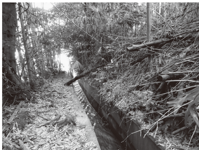
用水路の状況
