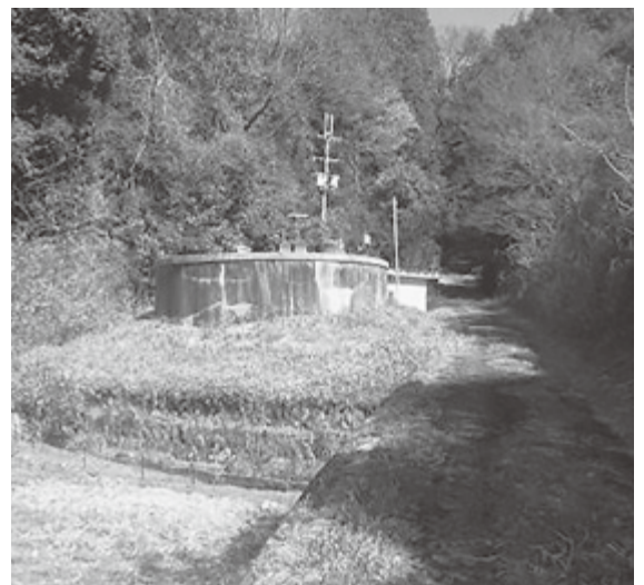
二河原辺低区配水池
