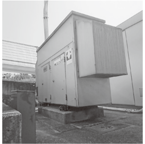
くすのきホールの非常用発電機
