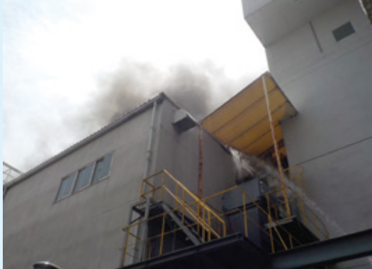
建屋屋上から黒煙がのぼる
